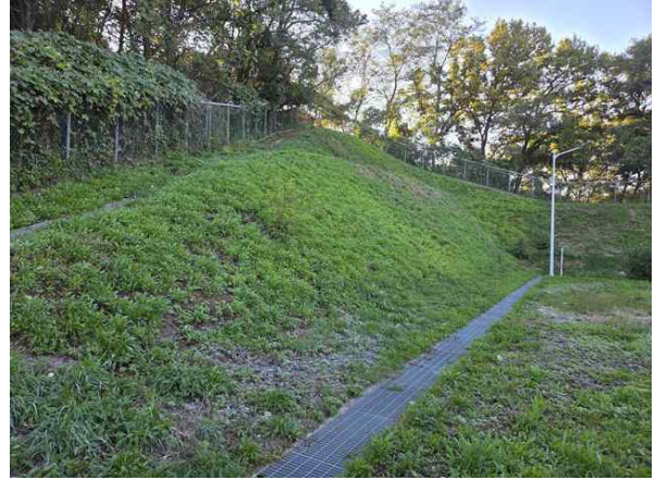
<부대시설 사면(성토부) 상태현황>
