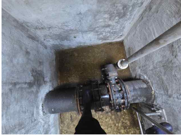
<유입밸브실 1지 바닥슬래브 채수>
