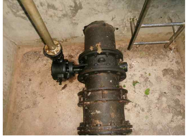
<유입밸브실 2지 상태양호>
