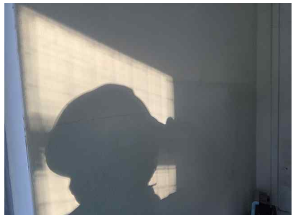
<전기실 내부 벽체 균열>
