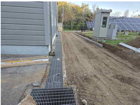
<부재시설 배수로 상태양호>
