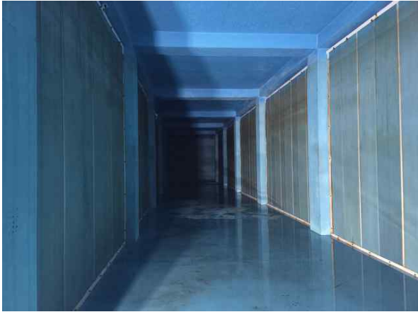
<배수지 1지 전경>
