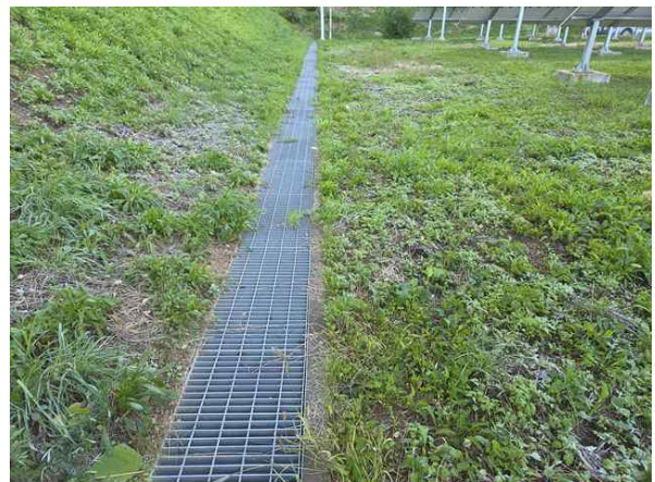
<부대시설 배수지 주변 사면 토사유실(상태양호)>
