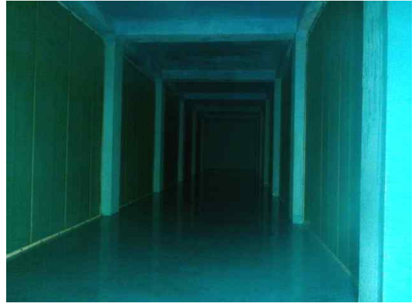
<배수지 2지 전경>
