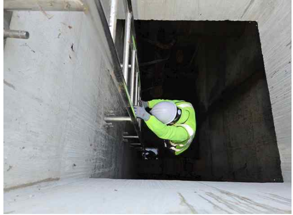
<내부 개별부재 외관조사>
