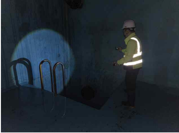
<내부 개별부재 외관조사>
